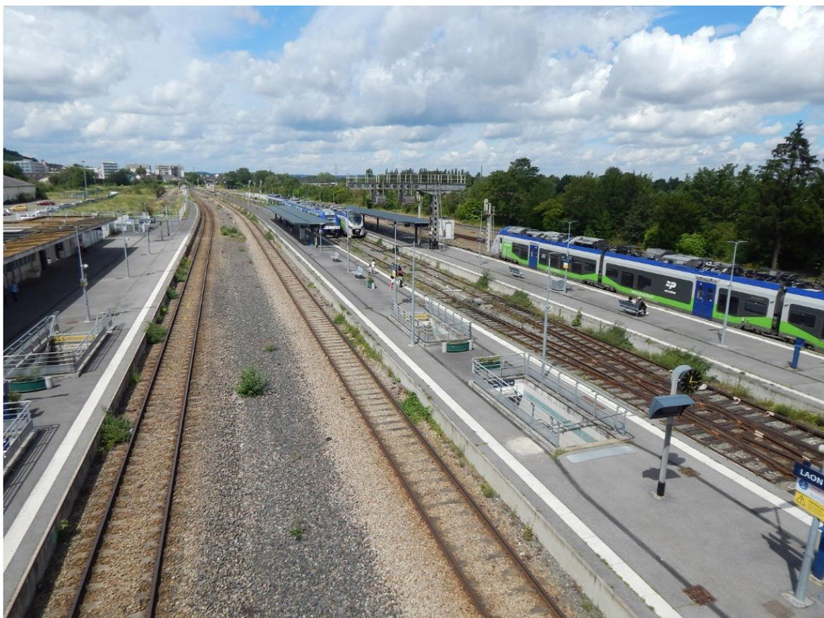
On notera que le passage souterrain ne dessert pas le 3<sup>ème</sup> quai... Il y avait sûrement une TVP, mais celle-ci a dû être supprimée lors de la mise en service de la passerelle.
